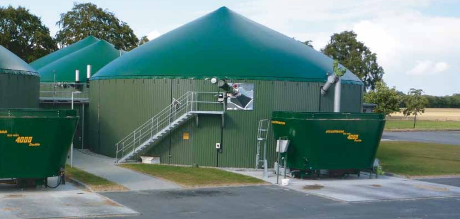
Optimales Befüllen von Beton- und Metallfermentern
